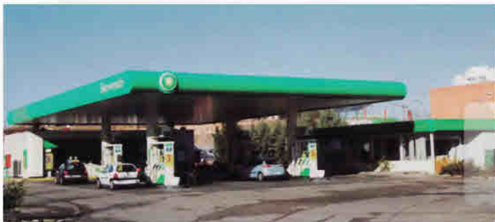
Estación de Servicio Valdavia
